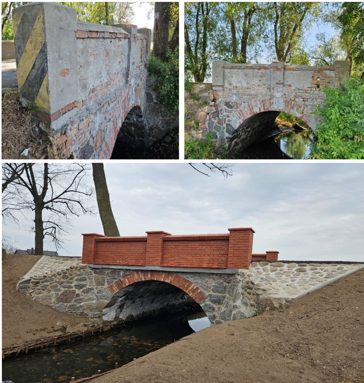
Fot. nr 19. Przebudowa drogi i mostu w Kłębanowicach.
