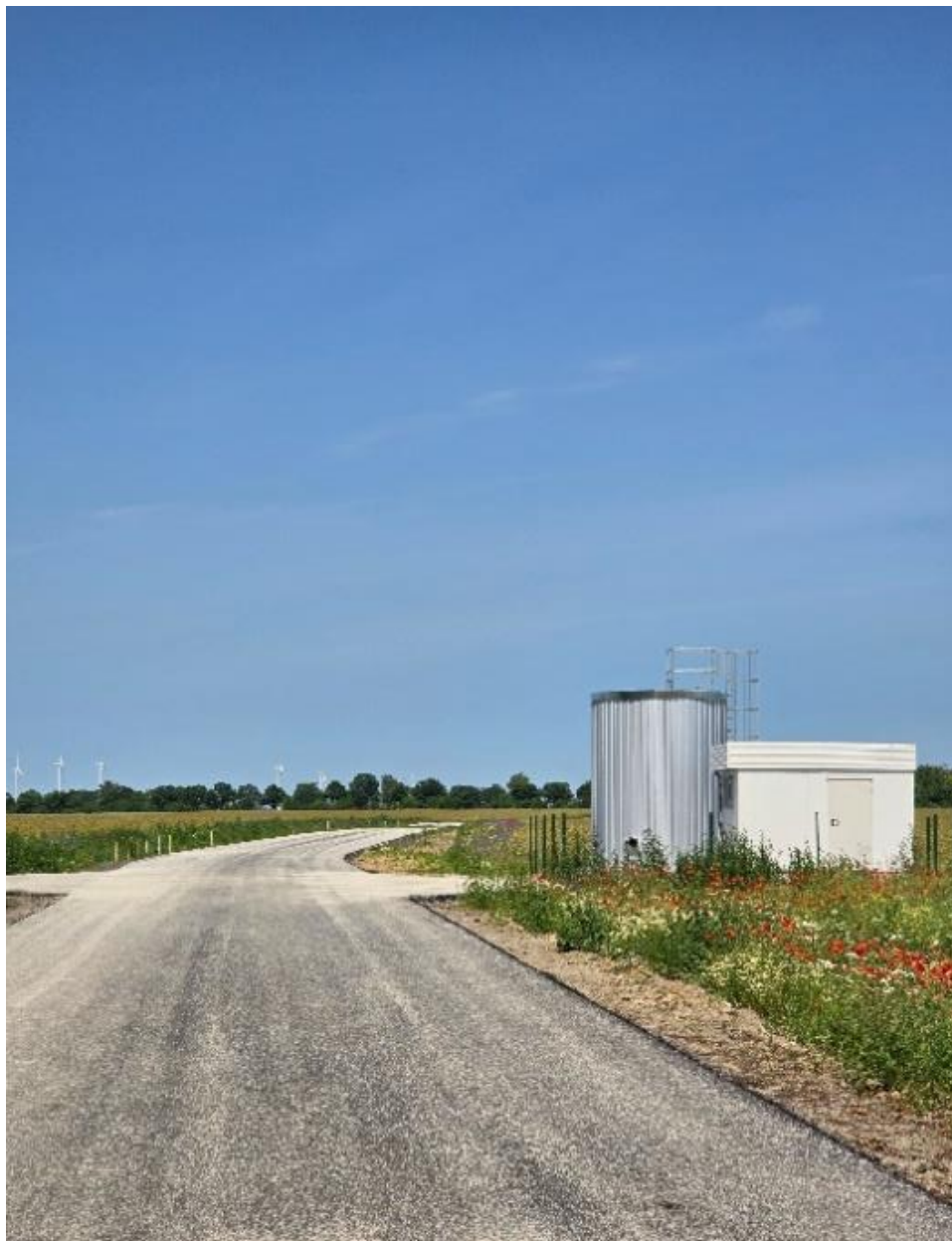
Fot. nr 23. Przepompownia wody Przesieczna- Drożyna.
