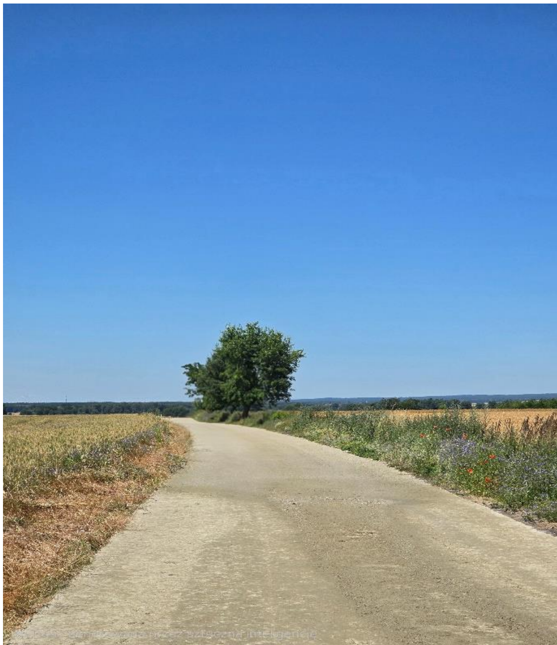
Fot. nr 22. Przebudowa drogi w stronę Kłobuczyna.
