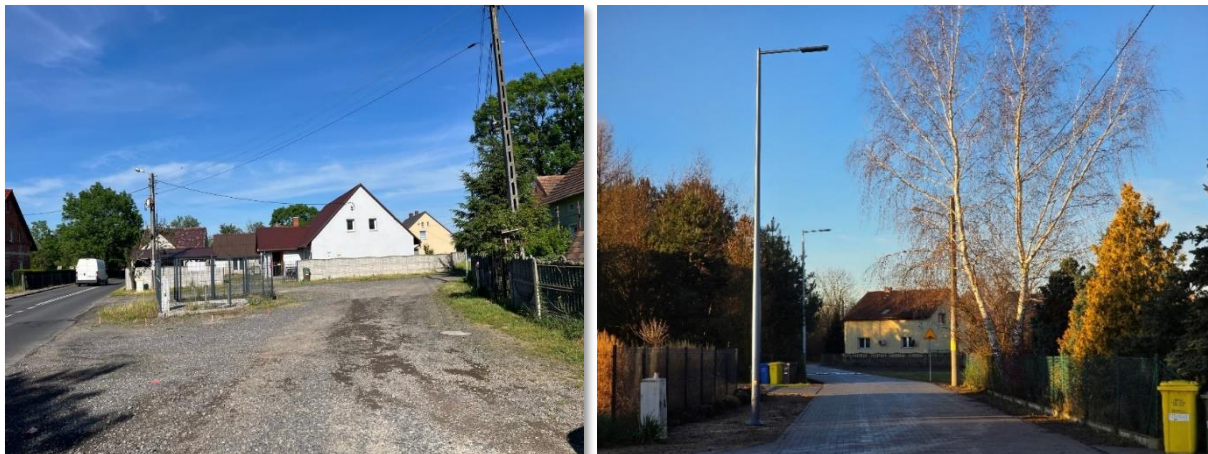
Fot. nr 29. Droga w Kłębanowicach przed i po przebudowę.
