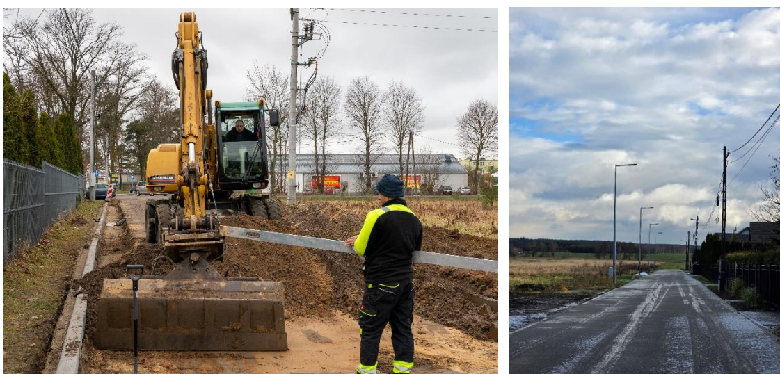
Fot. nr 31. Budowa ul. Goździkowej w Radwanicach.
