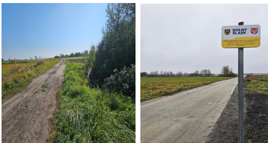
Fot. nr 21. Droga Radwanice – Park krajobrazowy w Przemkowie.
