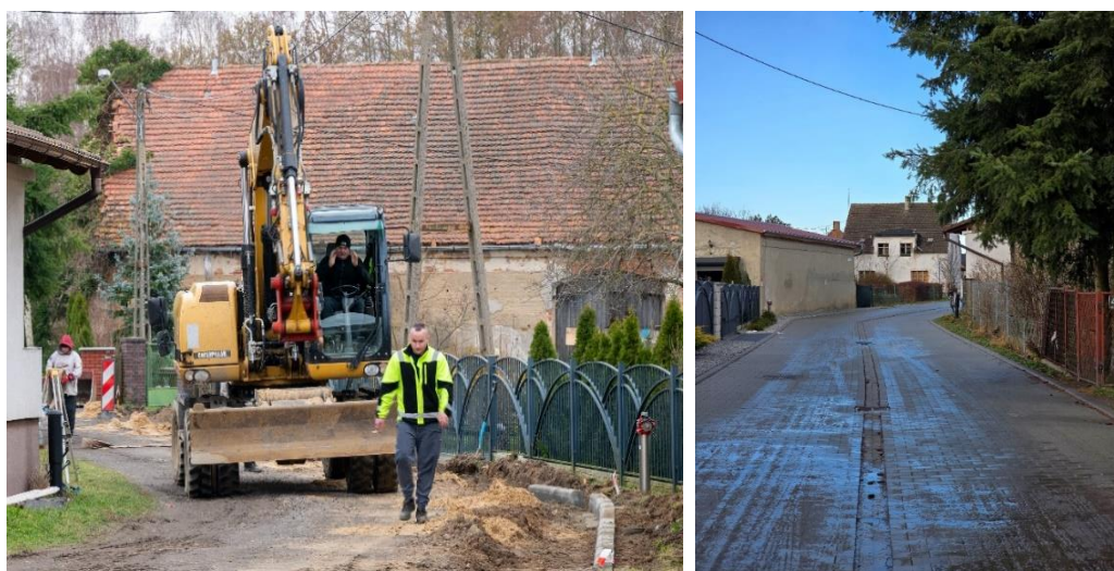
Fot. nr 30. Budowa ul. Prostej w Radwanicach.
