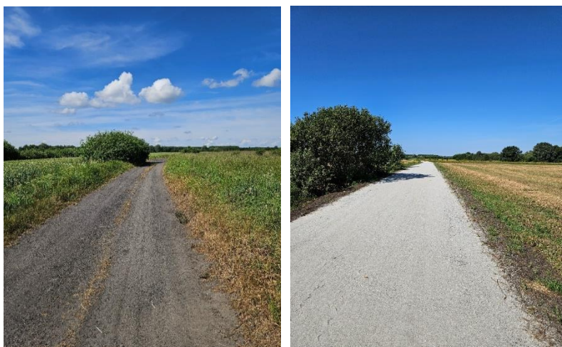
Fot. nr 20. Droga Radwanice – Park krajobrazowy w Przemkowie.
