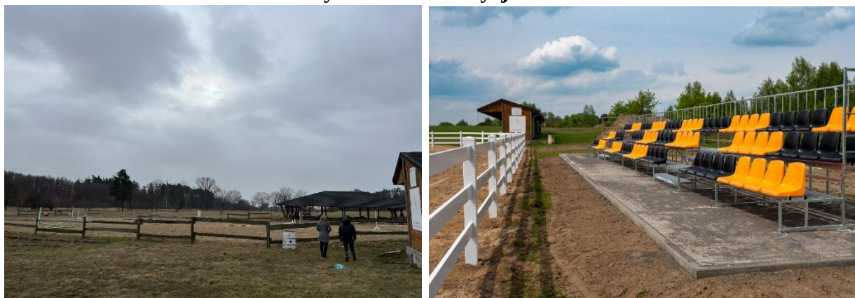
Fot. nr 26. Trybuny sportowe i ogrodzenie parkuru w m. Jakubów przed i po wykonaniu inwestycji.
