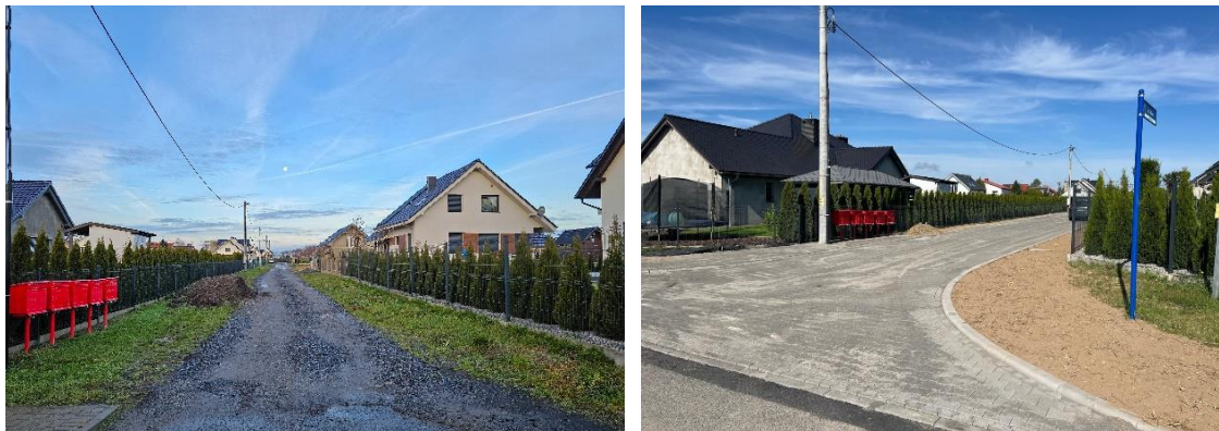
Fot. nr 32. ul. Kalinowa w Radwanicach przed rozpoczęciem budowy oraz po zakończeniu budowy.
